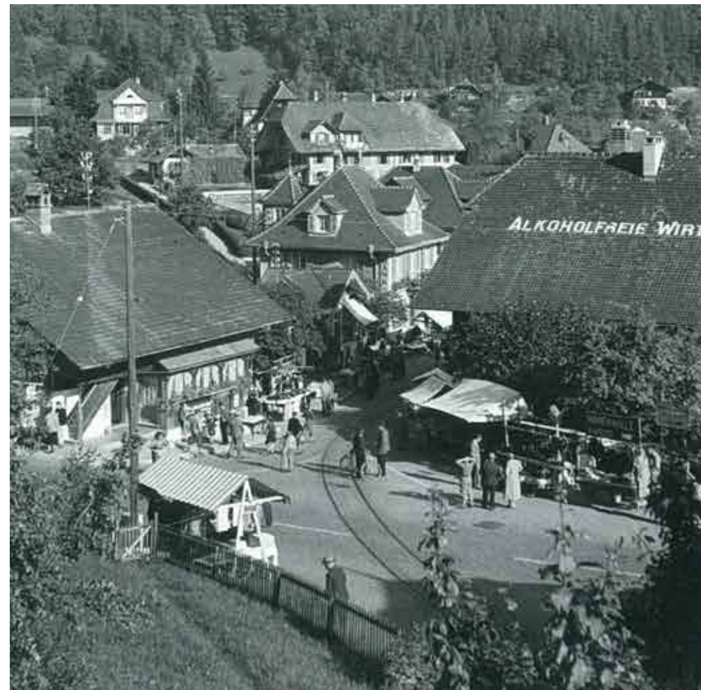
Wo heute die Fahrzeuge den Kronenplatzkreisel umrunden, herrschten enge Platzverhältnisse, wie das Bild vom Spiez-Märit um 1950 zeigt. Anstelle der Gemeindestube mit «Alkoholfreier Wirtschaft» steht heute das Gebäude der Kantonalbank. Auf dem Platz selbst ist das Gleis der Spiezer Verbindungsbahn zu sehen, die von 1905 bis 1960 zwischen dem Bahnhof und der Schiffländte verkehrte.
