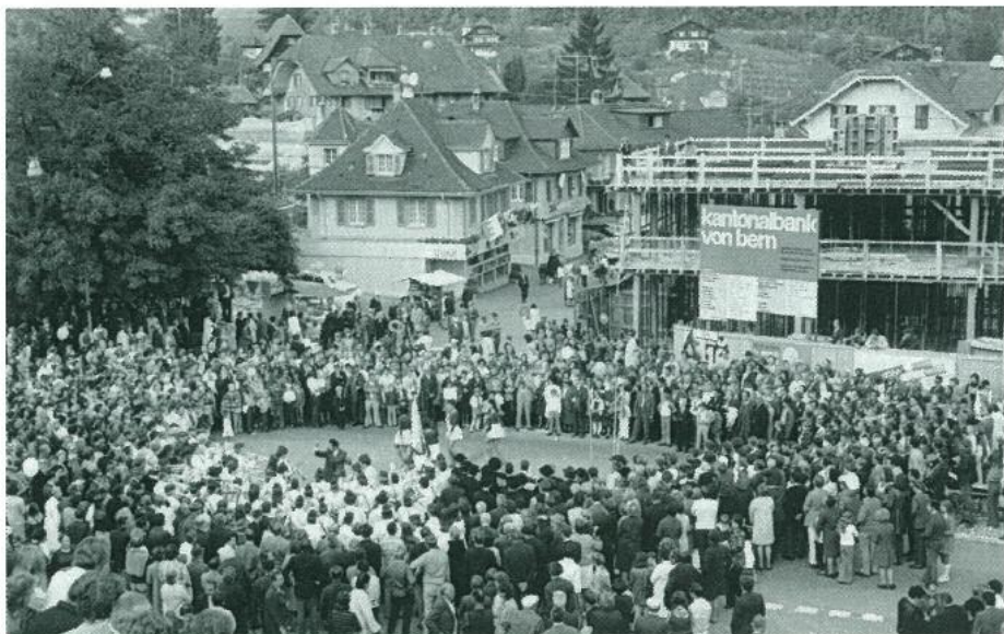
1971: Unterhaltungsprogramm auf dem Kronenplatz. Die Kantonalbank ist im Bau.
